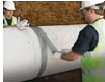
Entourez la zone de réparation.
