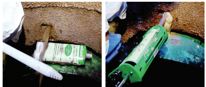
La infiltración de agua subterránea reparada en minutos!
